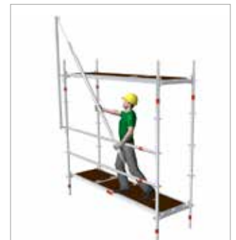
Image 68 : Accrocher la lisse de garde-corps MSG
